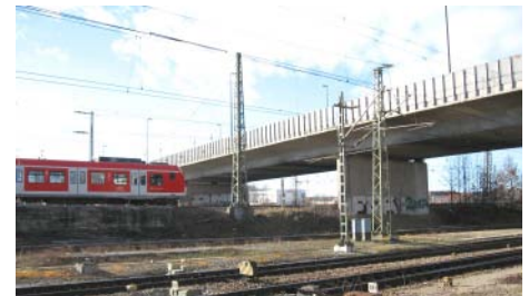
An dieser Stelle wird die neue Station "Friedenheimer Brücke" entstehen.
